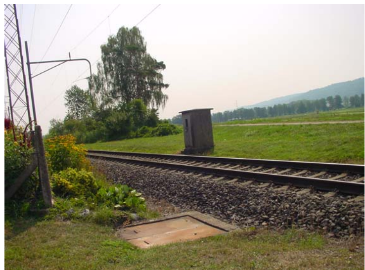
Sicht des Autofahrers vor dem unbewachten Bahnübergang Richtung Buchs-Dällikon, der Richtung des herannahenden Güterzuges
