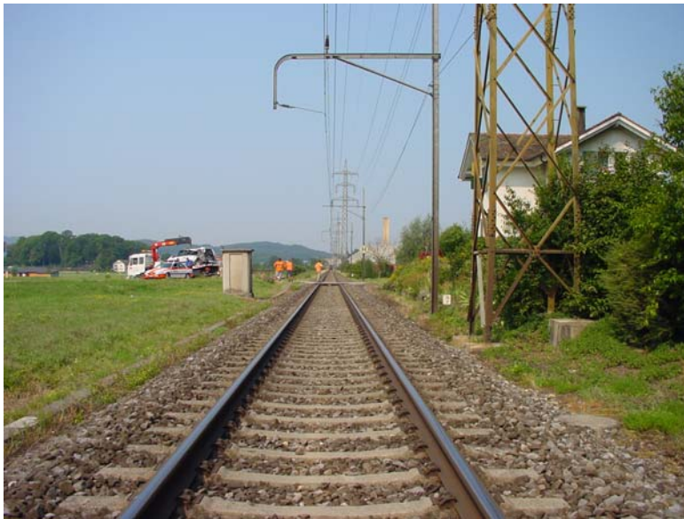
Sicht des Lokführers auf den unbewachten Bahnübergang. Das Auto kam von rechts.
