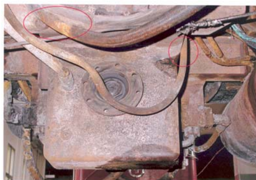
Montage des tuyaux hydrauliques
