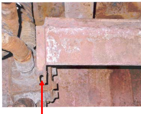
Trou recevant la vis d'arrêt
